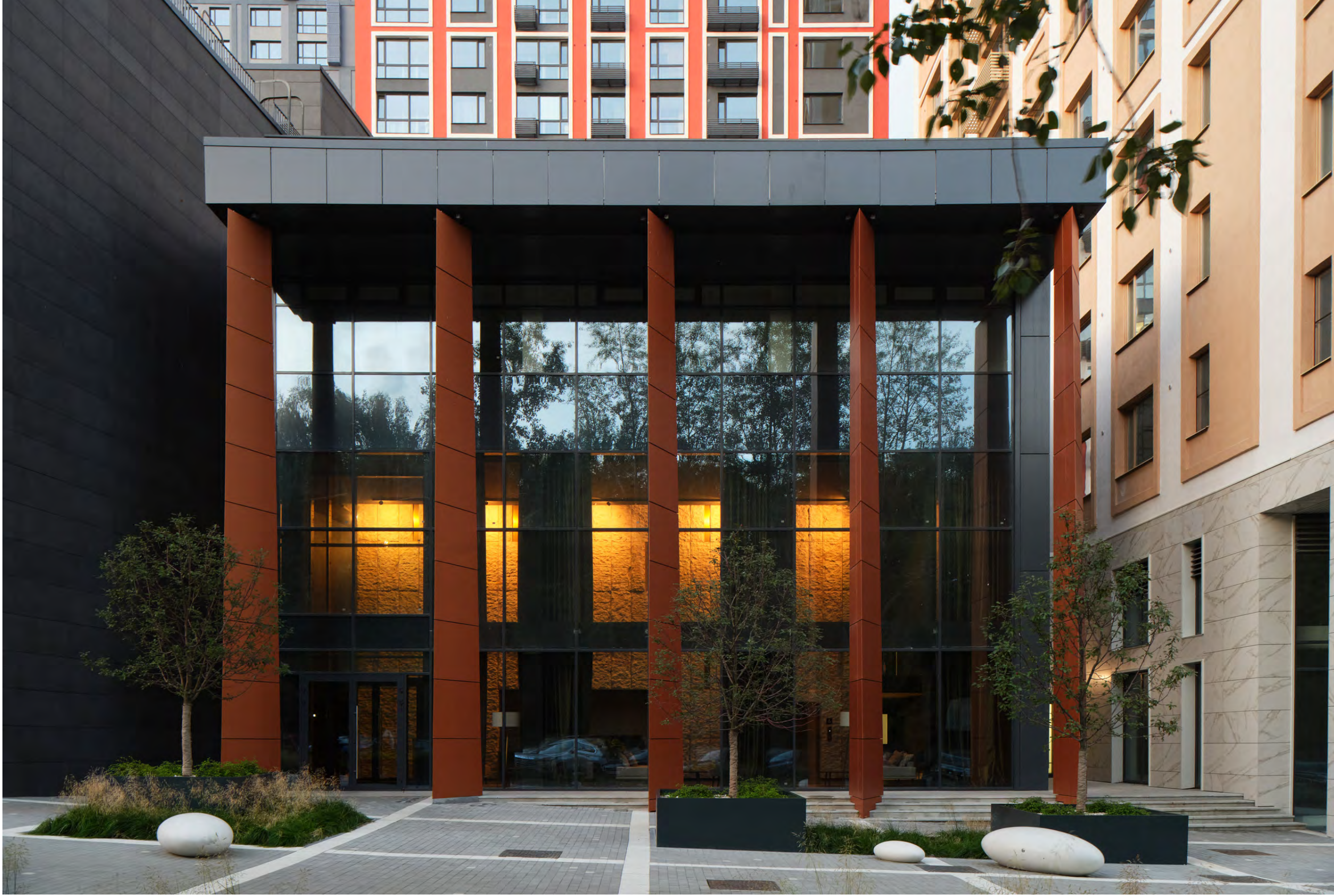
Вид на общественное здание
