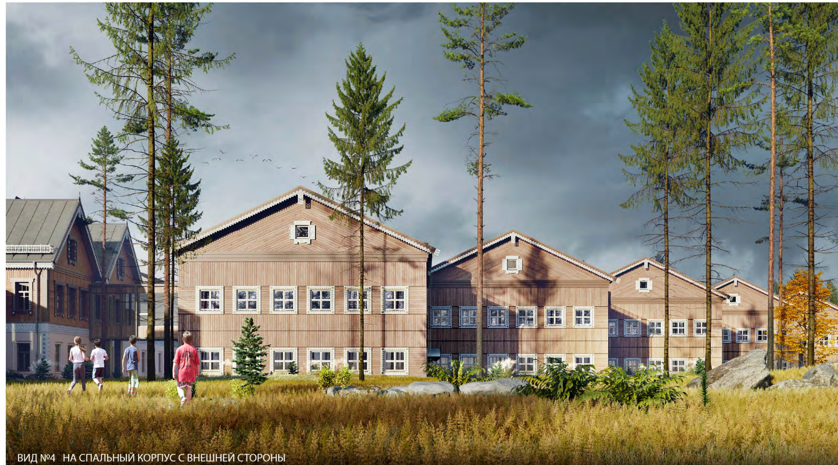
ВИД №4 - НА СТАЛЬНЫЙ КОРПУС С ВНЕШНЕЙ СТОРОНЫ
