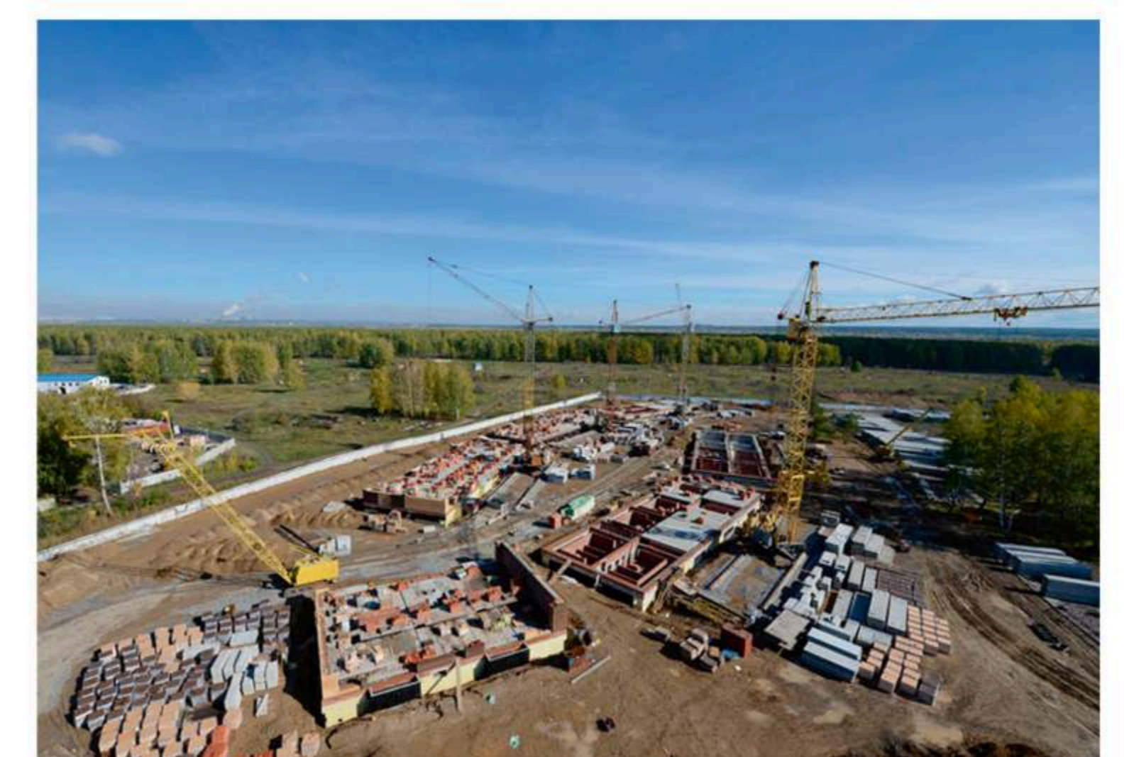
ФОТОФИКАЦИЯ СО СТРОЙКИ
