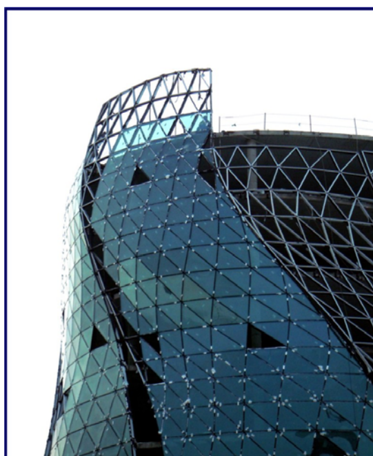
Рис. 6. Строящееся общественное здание в Новосибирске (арх. В.Н. Филиппов)
