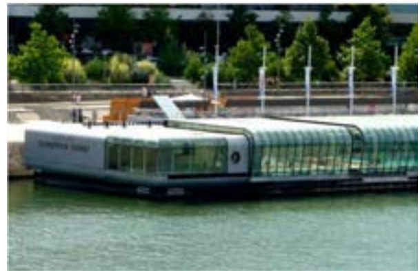
Рис. 18. Трансформируемое покрытие бассейна Piscine Joséphine-Baker, Париж
