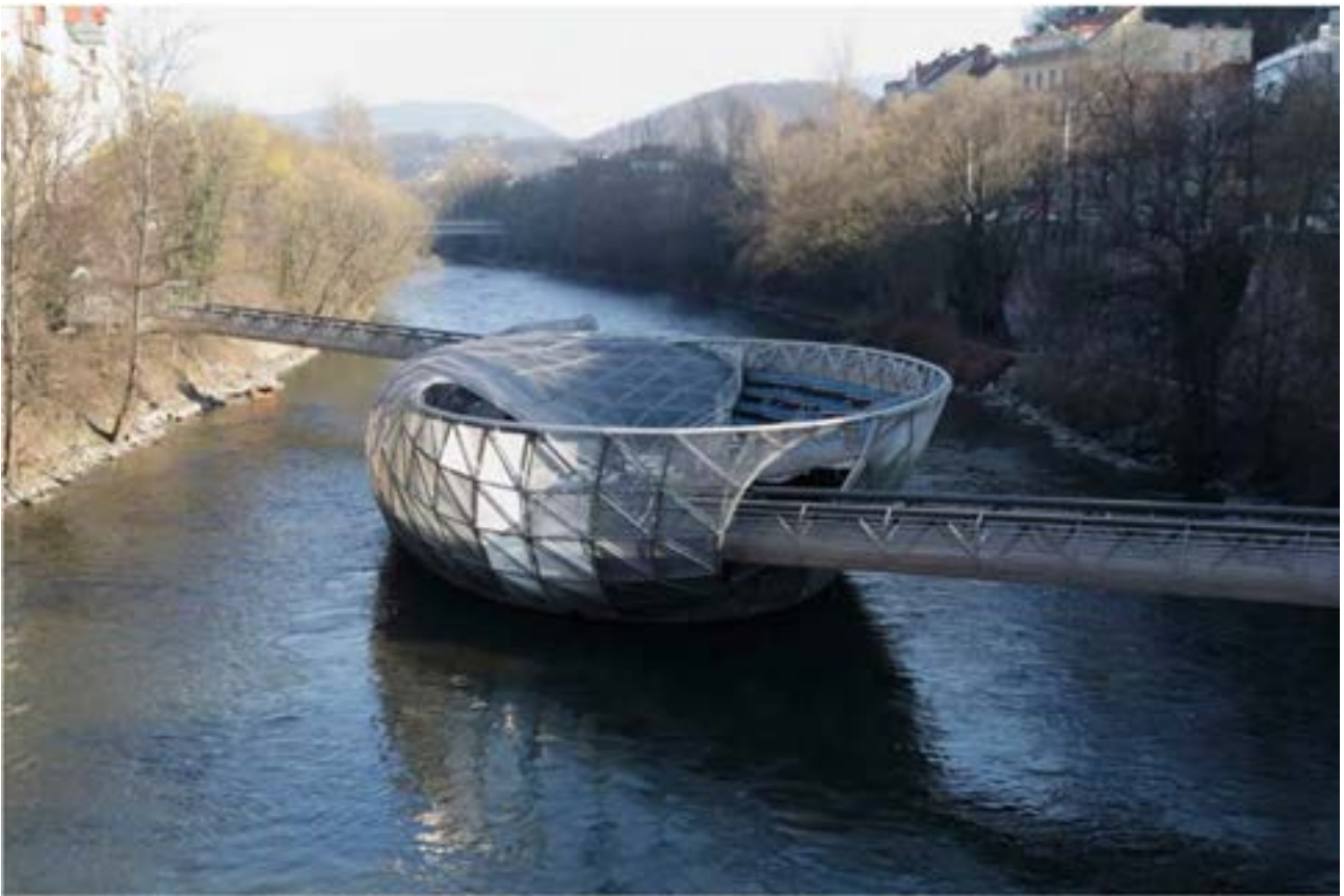
Рис. 118. Мост-остров Муринзель, Австрия
