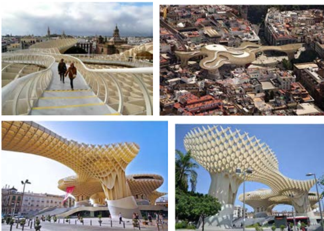
Рис. 8. Самая большая в мире деревянная конструкция Metropol Parasol в Севилье, Испания. Фотография: jtmayerh.de
