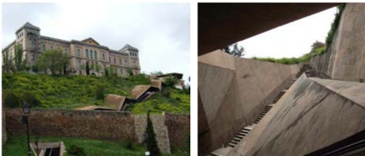
Рис. 52. Эскалаторы и лестница в Толедо, Испания
